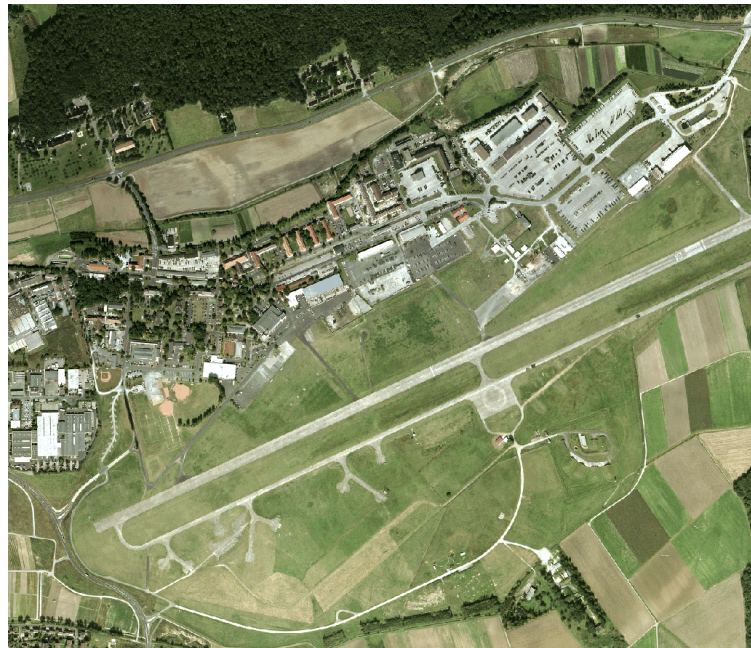
Luftbild „Harvey-Barracks“ Kitzingen
