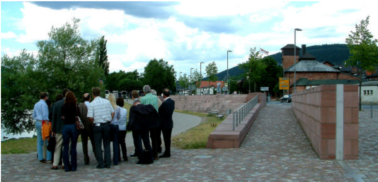
Tagungsteilnehmer bei der Besichtigung des Hochwasserschutzes
